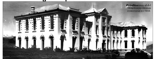
Fig. 5 Hospital de Miraflores
