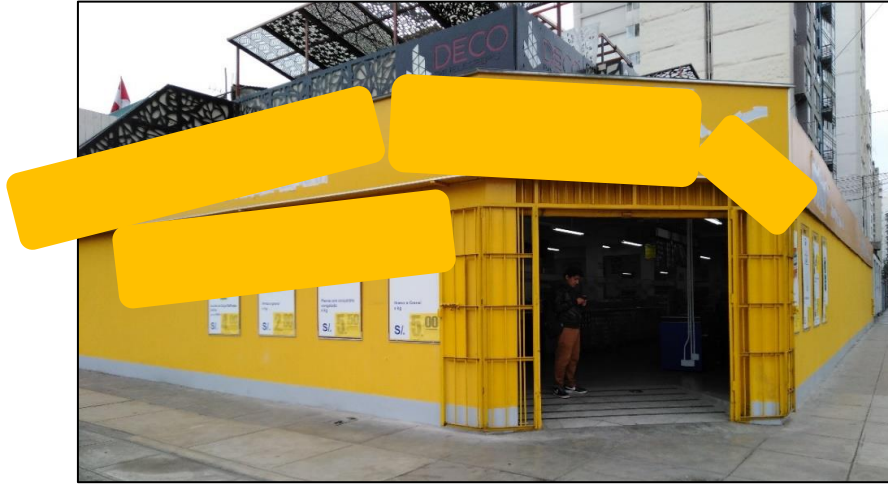
Figura 2: Fachada de primer proyecto retail.
