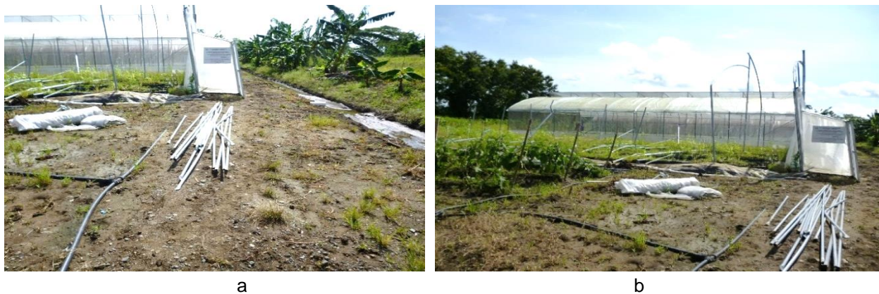
Figura 5. Efecto de tornado sobre la estructura de invernadero, lo que obligó a suspender la investigación en berenjena china de la variedad Chun Hua (F1): a. vista parcial y b. panorámica global del invernadero caído.
