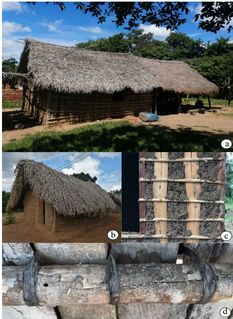
Figura 8. Material de construcción. a. Techo construido con base a las hojas del motacú motacú ( Aitalea phalerata ) y la paja saeta ( Trachypogon spicatus ); b. techo construido con hojas del motacú ( Aitalea phalerata ); c. pared de barro mezclada con paja carona ( Elyonurus muticus ), soporte de guapá ( Guadua paniculata ) y madera; d. fibra de amarre de güembé ( Philodendron undulatum ).
