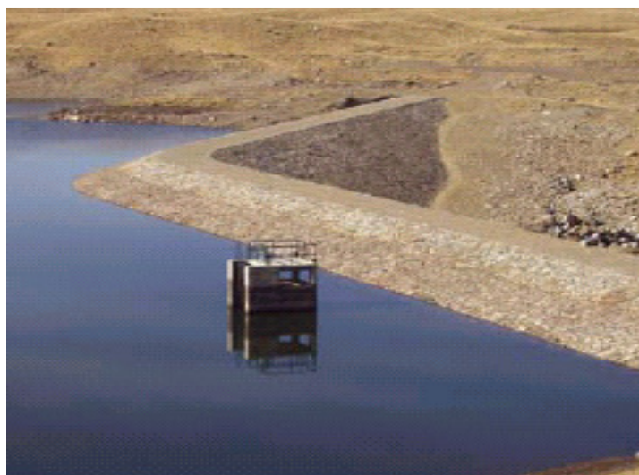
Figura 2: Fotografía de presa de tierra: Chankas en Tiquipaya – Cochabamba
