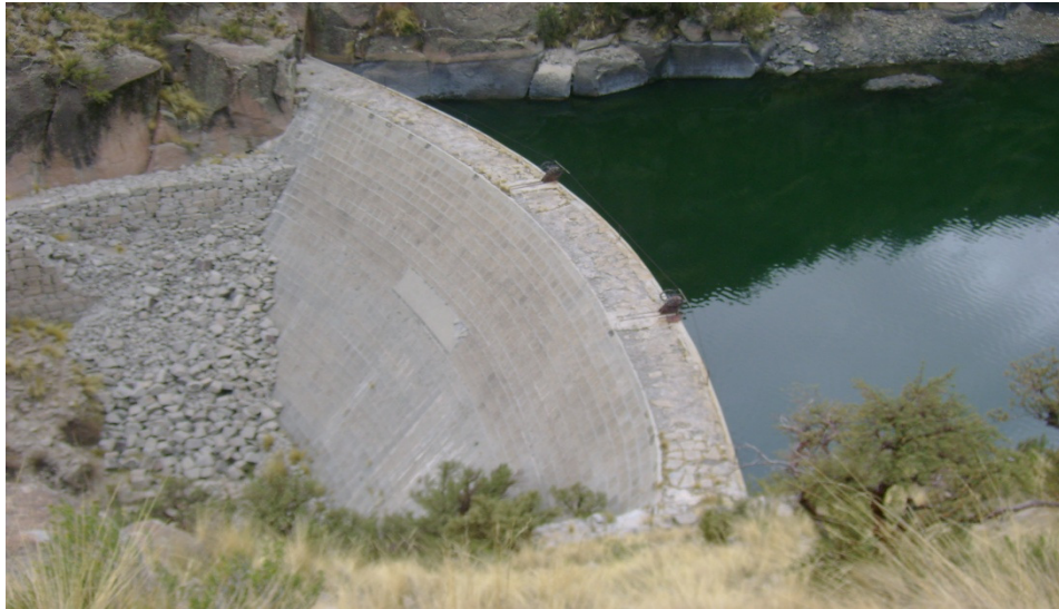
Figura 3: Fotografía de presa de arco - gravedad: Cayara en el Municipio de Yocalla - Potosí.
