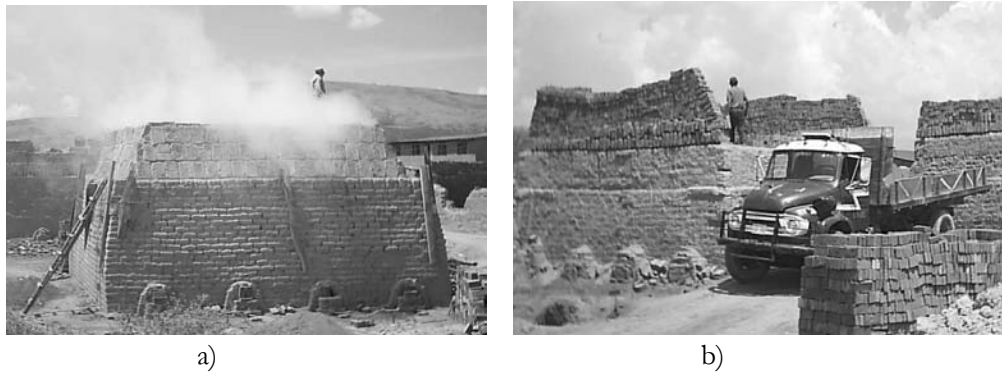
Figura 5: a) Cocción en hornos b) Extracción de ladrillos para la venta
