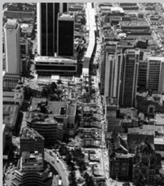
Foto 9. Se observa la intervención sobre Bolívar para la construcción del viaducto. A la derecha está el espacio para la Plazuela de las Esculturas Fernando Botero. Archivo de la Biblioteca del Metro de Medellín. [aprox. 1990-1995]
