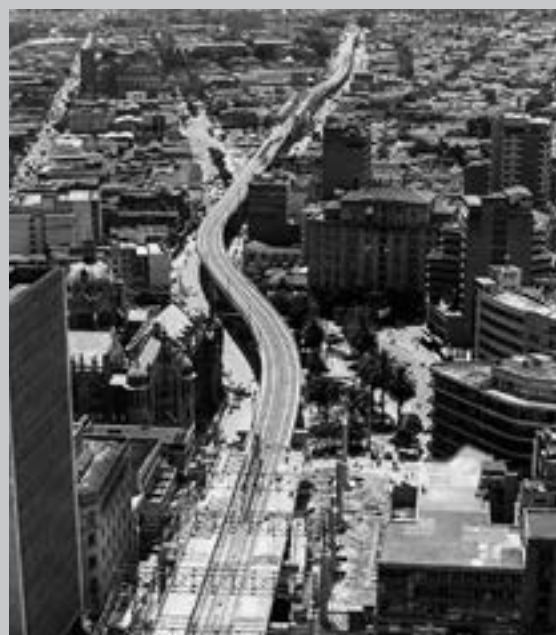
Foto 10. Construcción del viaducto del sistema Metro. Archivo de la Biblioteca del Metro de Medellín. [aprox. 1990-1995]
