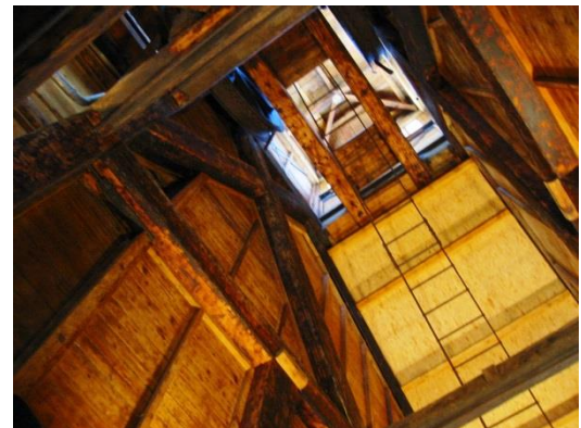
Interior del castillete del pozo de extracción. Museo minero (Arnau, España)
