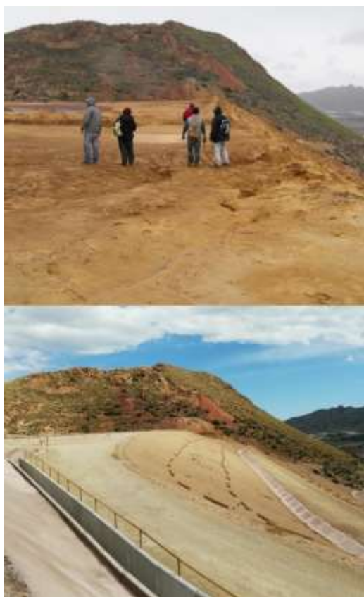
Figura 4. Imagen de perfil del dique de la presa San Cristóbal II (976-II-3-007) en el año 2011 (arriba) y en
