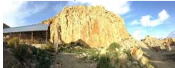
Figura 1: Talud – Caso de estudio.
