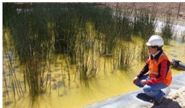
Foto 1. Wetland experimental para tratar aguas ácidas de mina.
