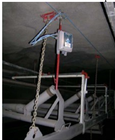
Figura 4. Detector de monóxido de carbono: (a) Instalación del detector en una galería de transporte y (b) Muestra de un detector de CO manufacturado por la Compañía Conspec.
