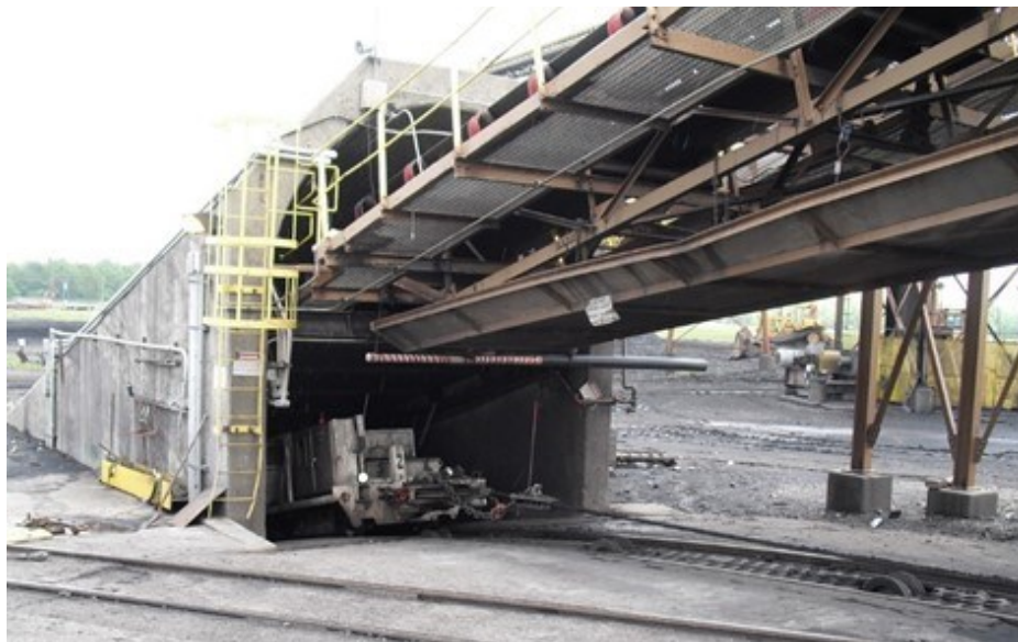
Figura 3. Banda transportadora en una rampa de extracción
