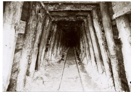
Figura 3. Socavón principal guiado sobre filón hacia 1940
