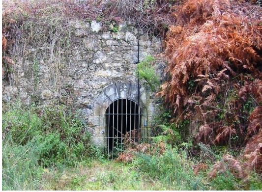
Figura 19. Bocamina de la galería 400
