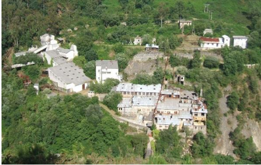
Figura 9. Complejo minero de Fontao (vista parcial)
