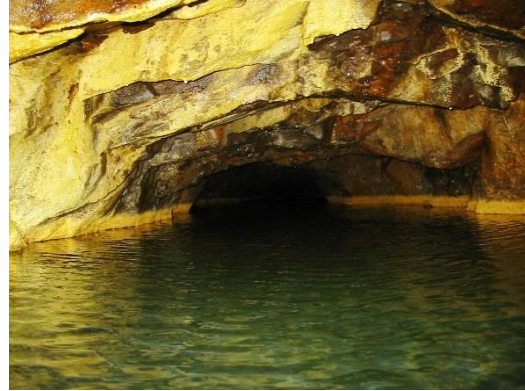
Figura 23. Galería 375 inundada con 1,50 m de altura de agua
